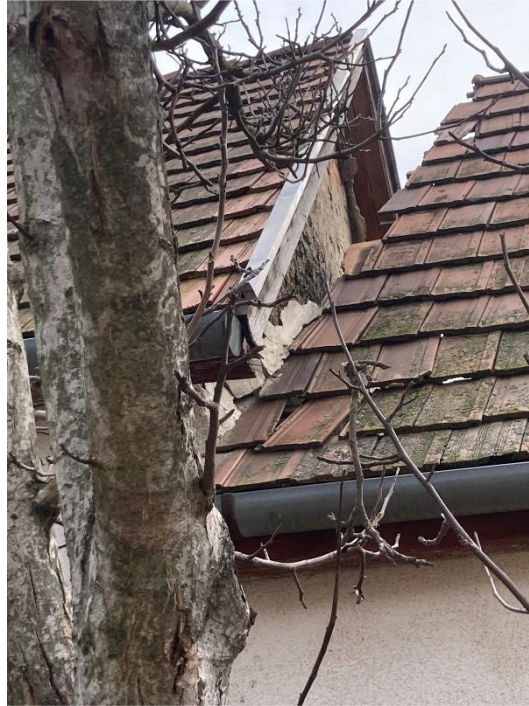
2. Oromfaltól eltávolodott tetővég
