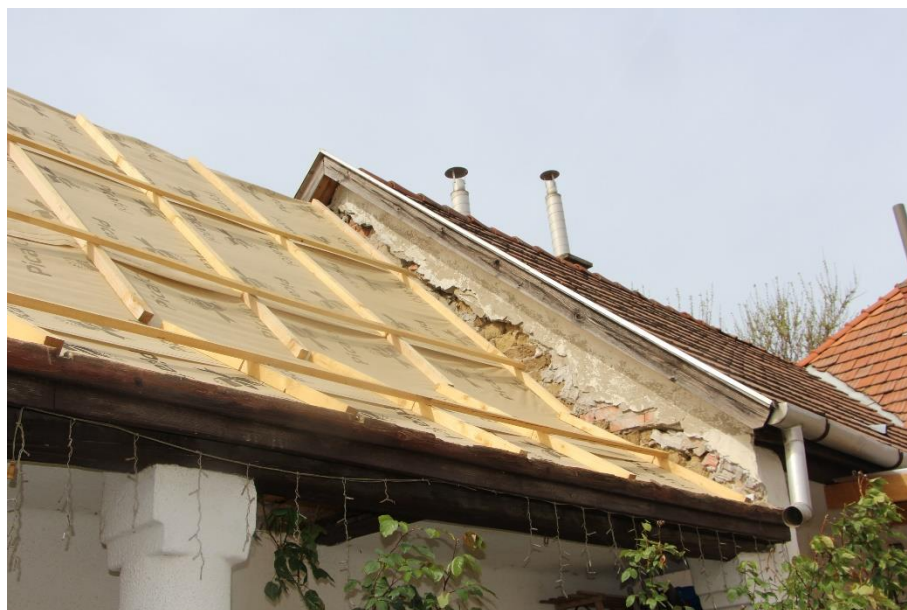
7. tetőcsatlakozás oromfalhoz
