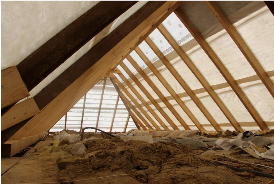
10. Új tetőszerkezeti elemek beépítése
