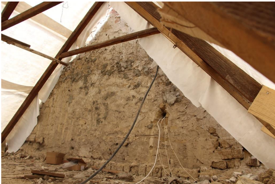
11. Megmaradó oromfal padlástérben
