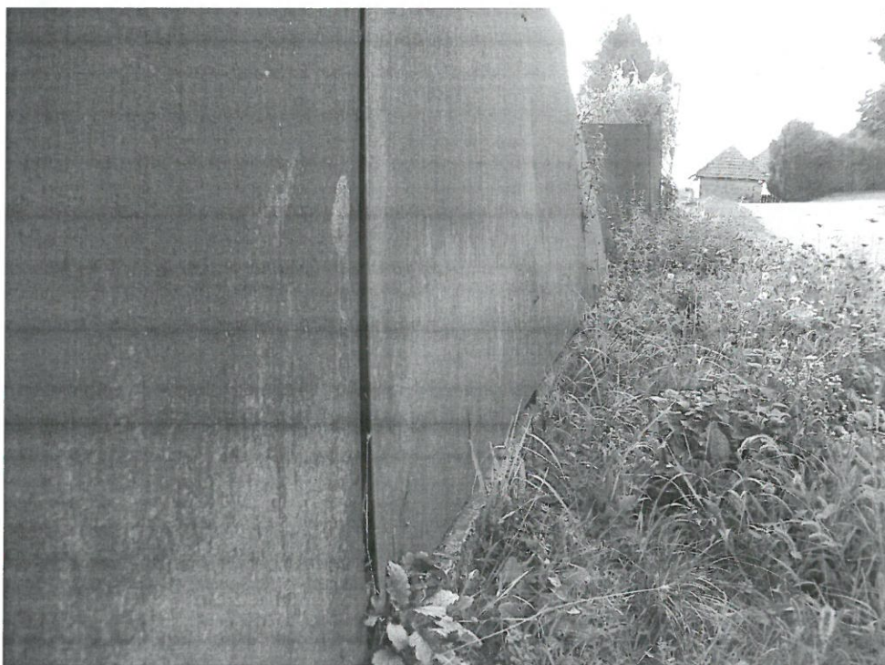
2.kép: A kibillent támfal feletti kerítés a lábazatával együtt szintén elbillent, a deformáció már dm-es nagyságú. A közút melletti padkán emiatt hosszanti övrepedések keletkeztek, a legnagyobb a kerítés lábazatának tövében jelent meg, mutatva a horizontális mozgásokat.
