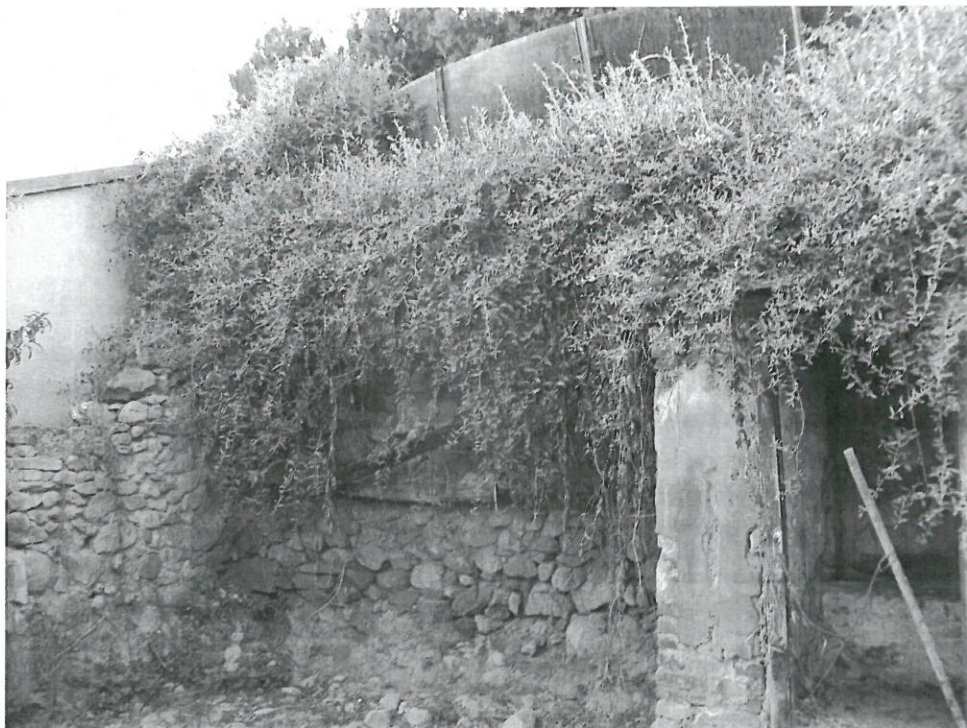
3.kép: A közeli felvételen jól látható a falazati anyag kiomlása, illetve a fal jelentős megbillenése. A harántfal és a NY-i oldali terméskő épület fal még támasztják a támfalat, ezért nem tudott az teljesen leomlani. A felső kerítés billenése itt is jól kivehető.
